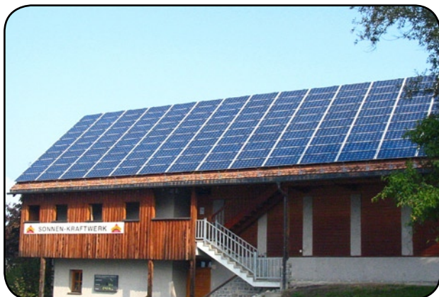
Installation collective de panneaux solaires photovoltaïques dans le Vorarlberg (Autriche)
